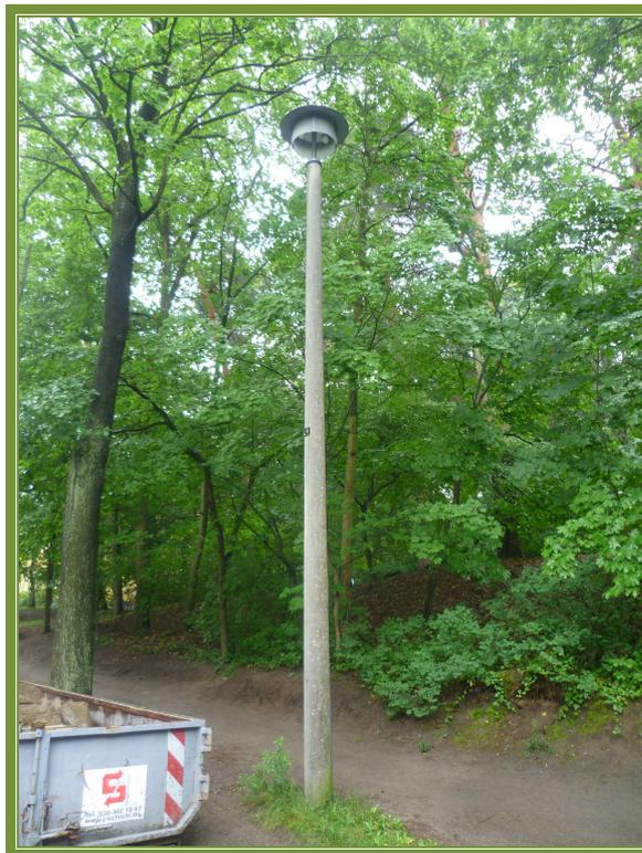
**Kleinmachnow** – Leuchte RSL 2x 50 W NAV; Betonmast 6,30 m
