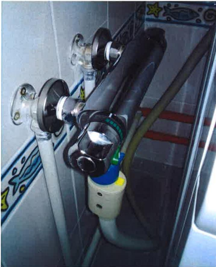
Abbildung 2: Thermostatventil zur Beladung der Waschmaschine mit warmen Wasser
