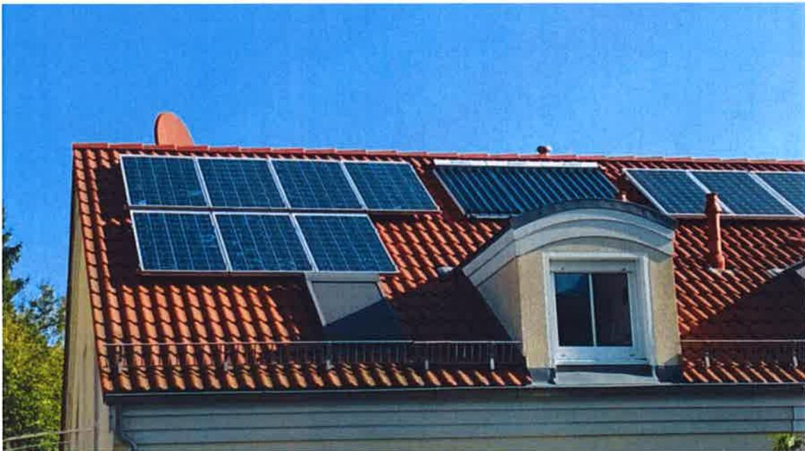
Abbildung 4: Dachaufteilung Stand 10/2013, 7 PV-Module, Röhrenkollektor; rechts beginnt die PV-Anlage des Nachbarn
