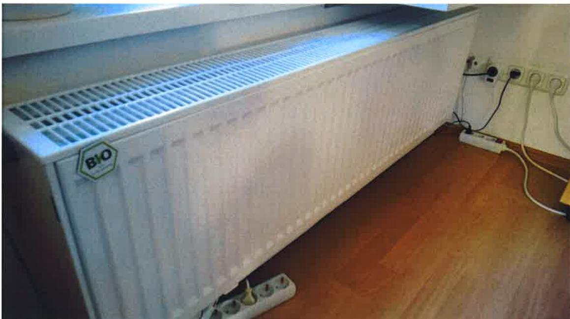
Abbildung 10: Vergrößerter Heizkörper für niedrigste Vorlauftemperaturen
