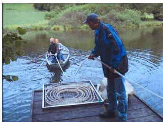
Abbildung 12: Verlegung des Belüftungssystems (Quelle: [www.gewaessersanierung.info](http://www.gewaessersanierung.info))
